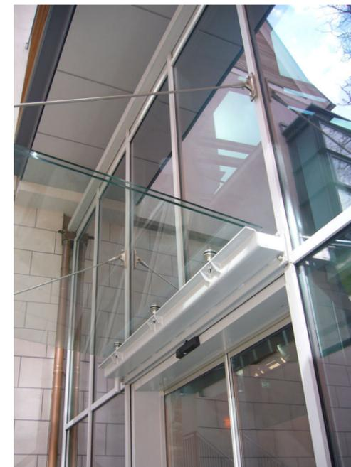
Dachrinne aus 8 mm Stahlblech feuerverzinkt und nach RAL pulverbeschichtet
